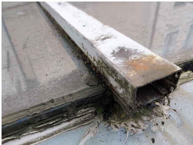
foto /3/ Pohled na těsnící profily a krycí lišty - fotografie z místního šetření [28] provedeného dne 03. 10. 2024
