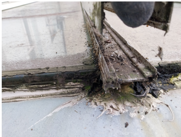
foto /4/ Pohled na těsnící profily a krycí lišty fotografie z místního šetření [28] provedeného dne 03. 10. 2024
